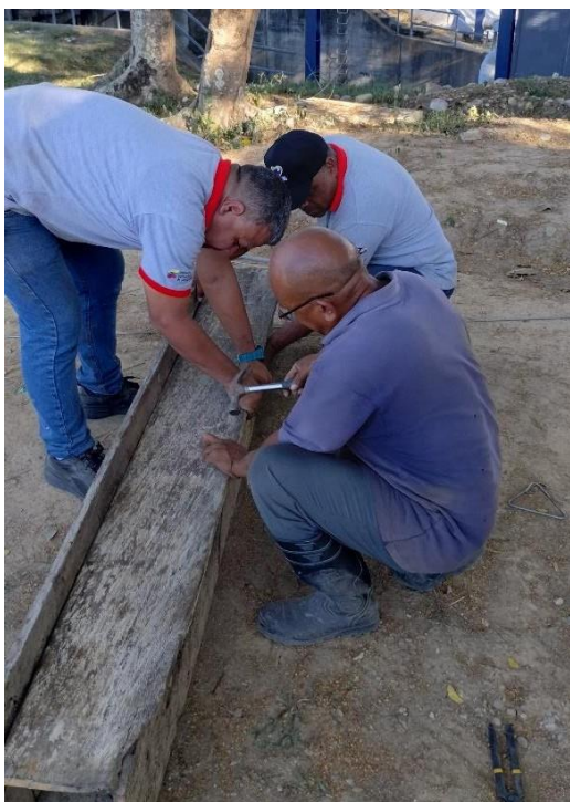
Figura 3. Construcción del Encofrado
