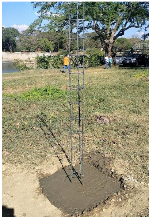
Figura 2. Vaciado de Concreto
