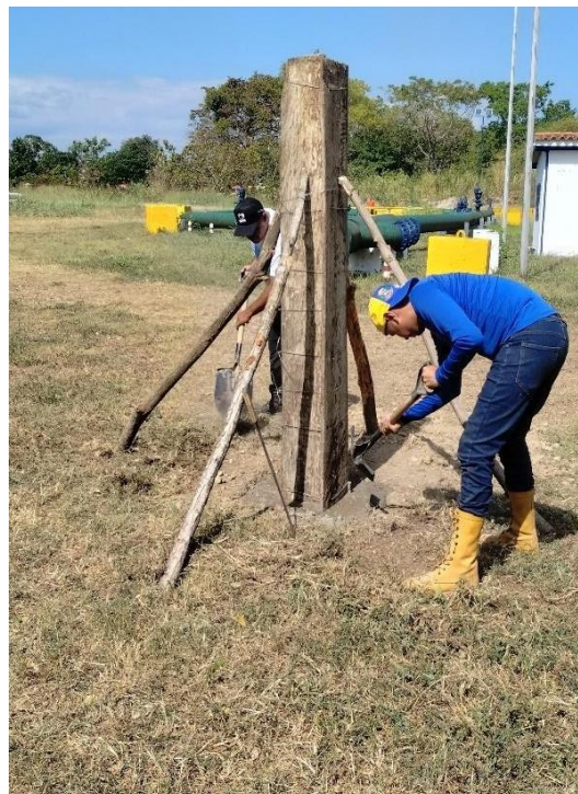
Figura 4. Colocación del Encofrado.
