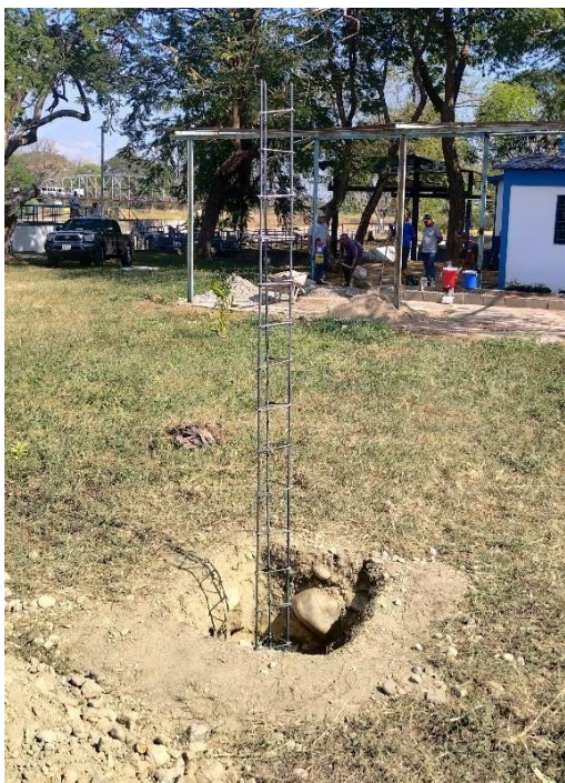
Figura 1. Excavación y columna.
