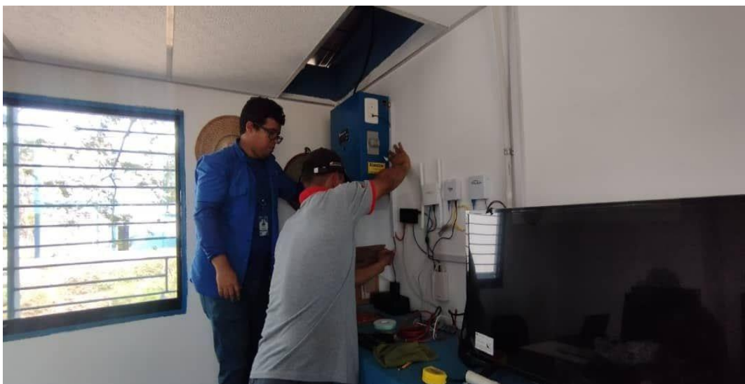
Figura 9. Instalación del Receptor Remos Barinas.
