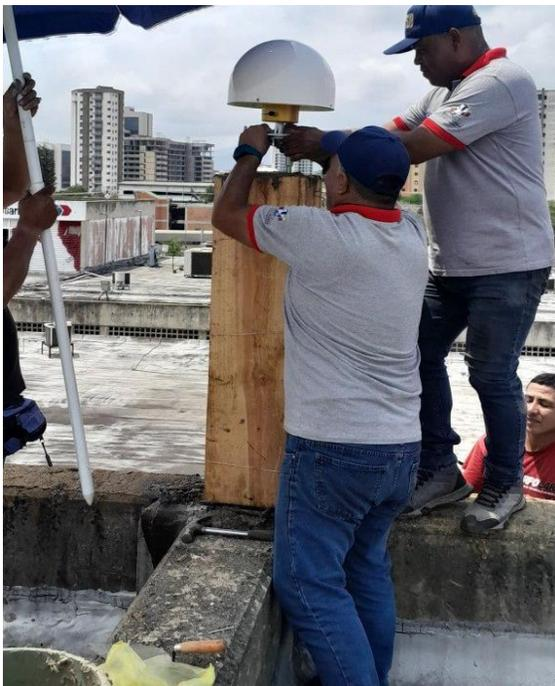
Figura 3. Colocación de la Antena GNSS
