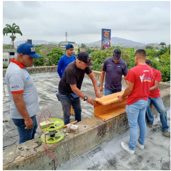
Figura 2. Construcción del Encofrado
