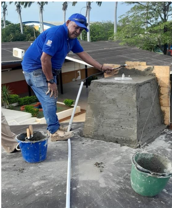
Figura 3. Colocación de la Tubería.
