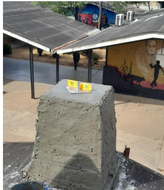
Figura 2. Construcción del Monumento
