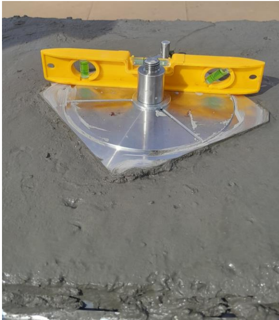
Figura 1. Colocación Base Nivelante.
