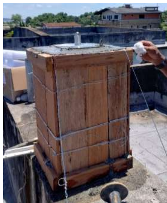
Figura 4. Encofrado.
