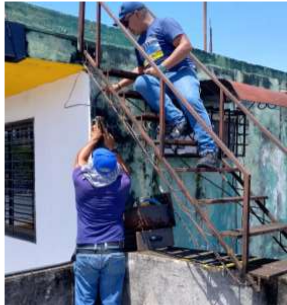
Figura 9. Colocación de la tubería Externa.
