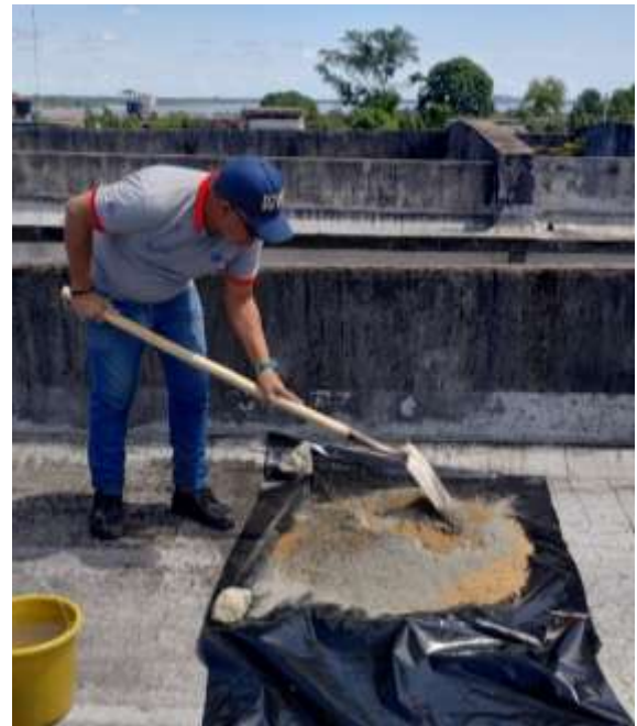
Figura 2. Preparación de la mezcla.
