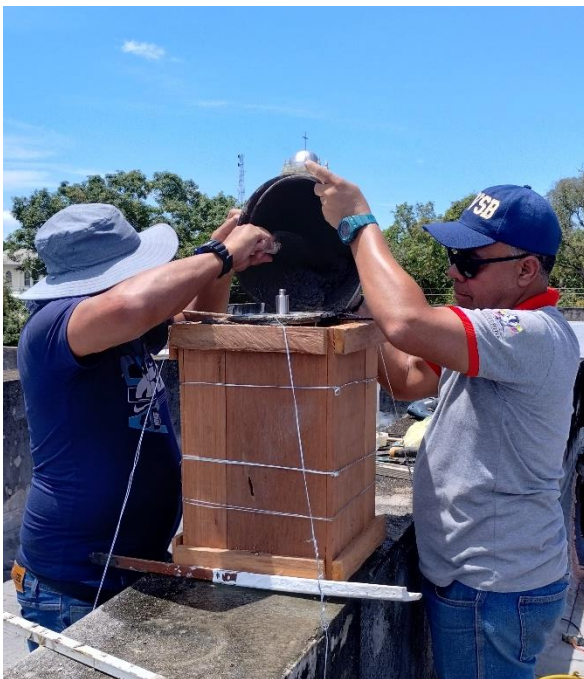
Figura 3. Vaciado de Concreto.
