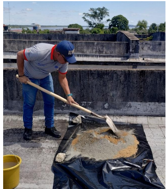
Figura 2. Preparación de la mezcla.
