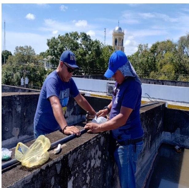
Figura 9. Colocación de la tubería Externa.
