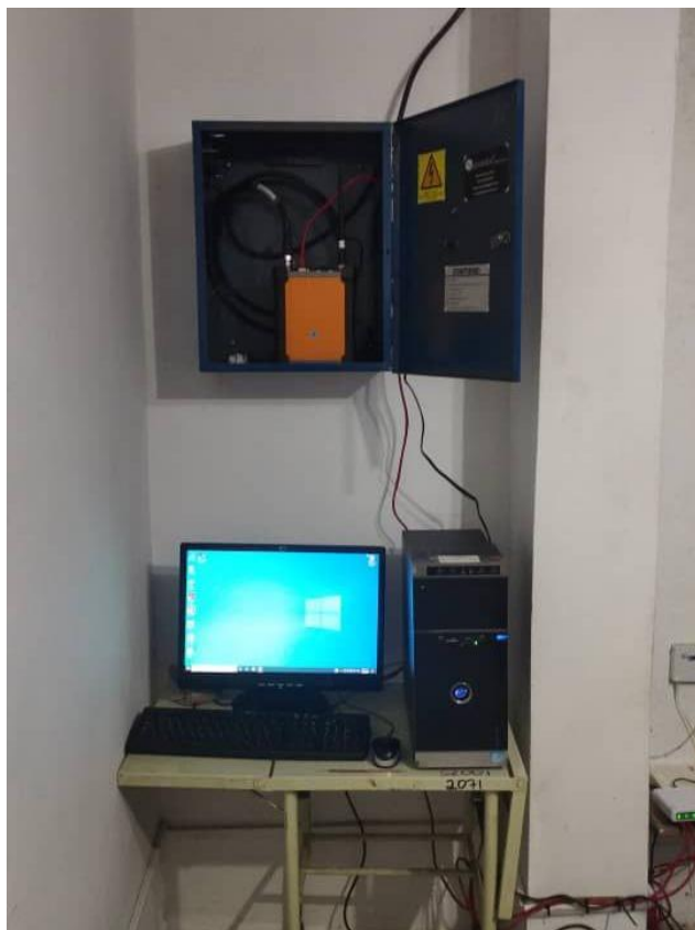
Figura 10. Cajetín con el Receptor y Conexión WIFI Remos Puerto Ayacucho.
