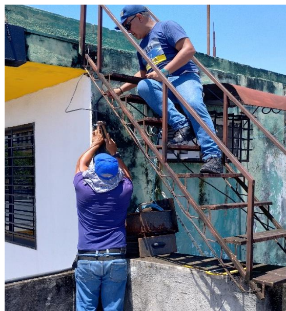
Figura 9. Colocación de la tubería Externa.
