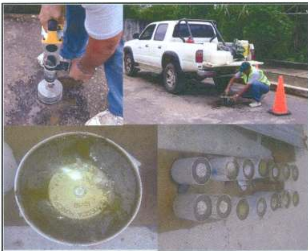
Figura 6: Monumentos. Construcción de vértices (monolito de concreto).
